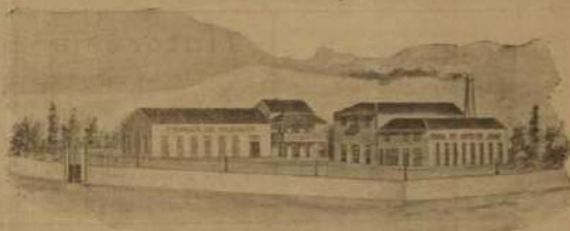
Vista general del edificio fábrica
