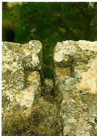
Detalle de los alojamientos para las piezas metálicas de anclaje de los sillares de coronación.
