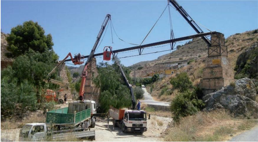
**Fig. 12. Canal de Ferro, durante las labores de sustitución debido a su deterioro. Año 2010. (Fotografía del autor).**
