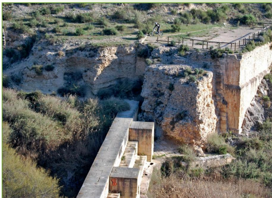
Restos de la presa del s. XVII, en el lado Norte, donde se pueden apreciar las diferencias de altura y espesor respecto al dique decimonónico
