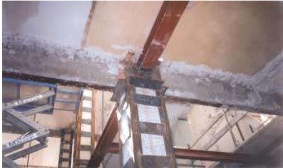
Encuentro del pilar de la planta baja y forjado, que se han reforzado con estructura metálica en la rehabilitación del edificio.
