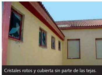
Cristales rotos y cubierta sin parte de las tejas.
