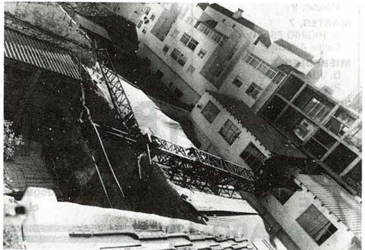
El brazo de la grúa que se desplazó a causa del viento, partiendo en dos la nave sobre la que aparece en la foto (Foto Ernes).
