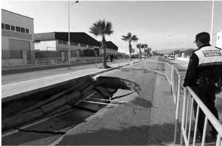
El socavón se produjo por una filtración de agua
