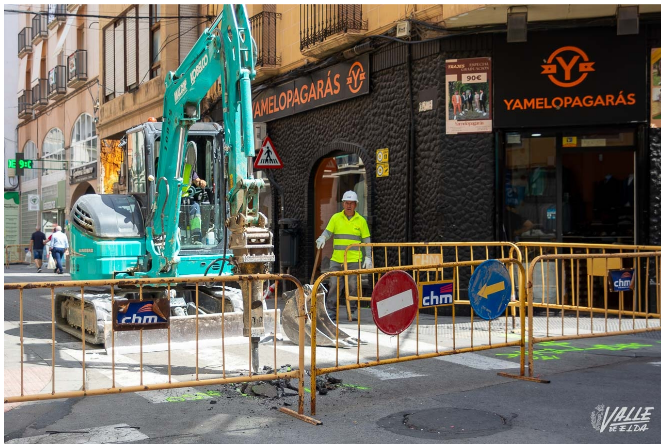
Imagen de archivo de las obras de la calle Ortega y Gasset | Marta Maestre
