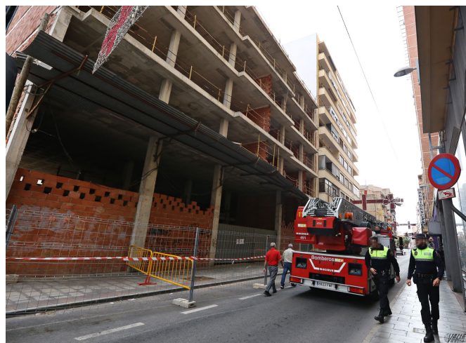
Los bomberos han reforzado la chapa de un edificio en la avenida de Chapí | Jesús Cruces.
