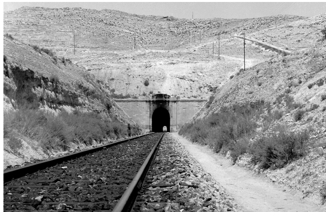
Imagen antigua del túnel de tren.
