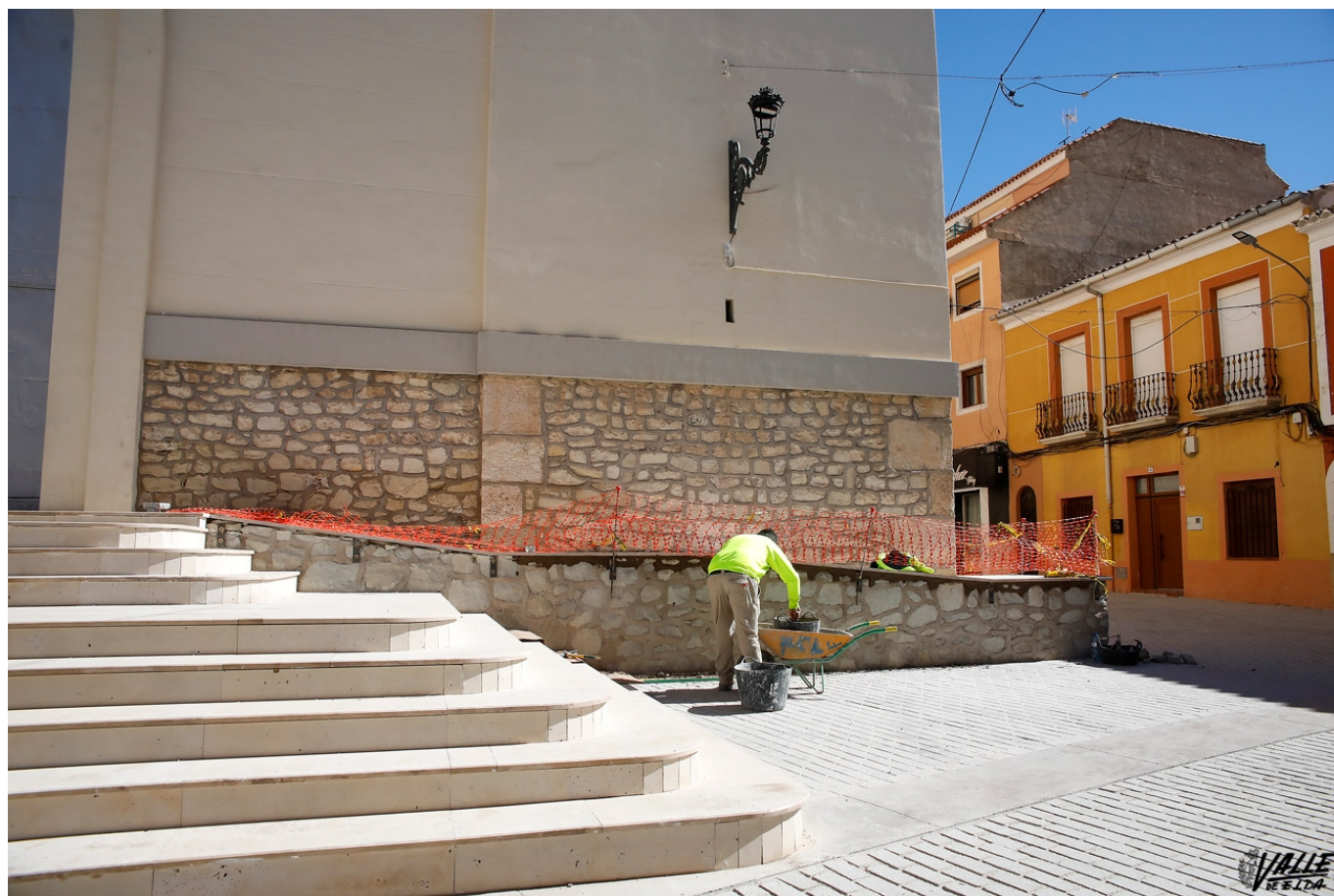
Los trabajos de la rampa entran en la fase final | Marta Maestre.
