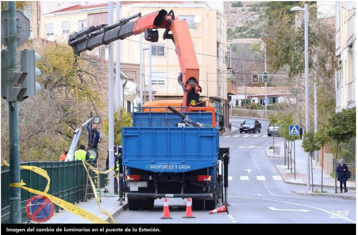
Imagen del cambio de luminarias en el puente de la Estación.
