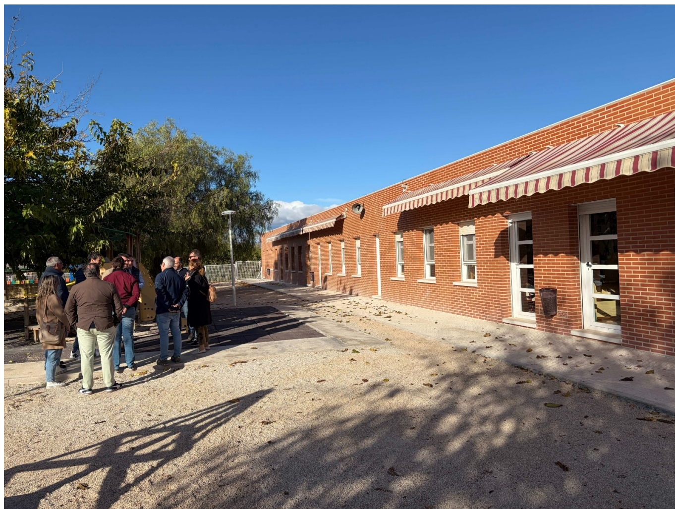
Las obras ya han concluido | Ayuntamiento de Petrer.
