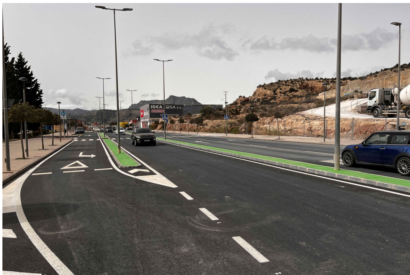
Las obras han durado varios meses | Ayuntamiento de Petrer.
