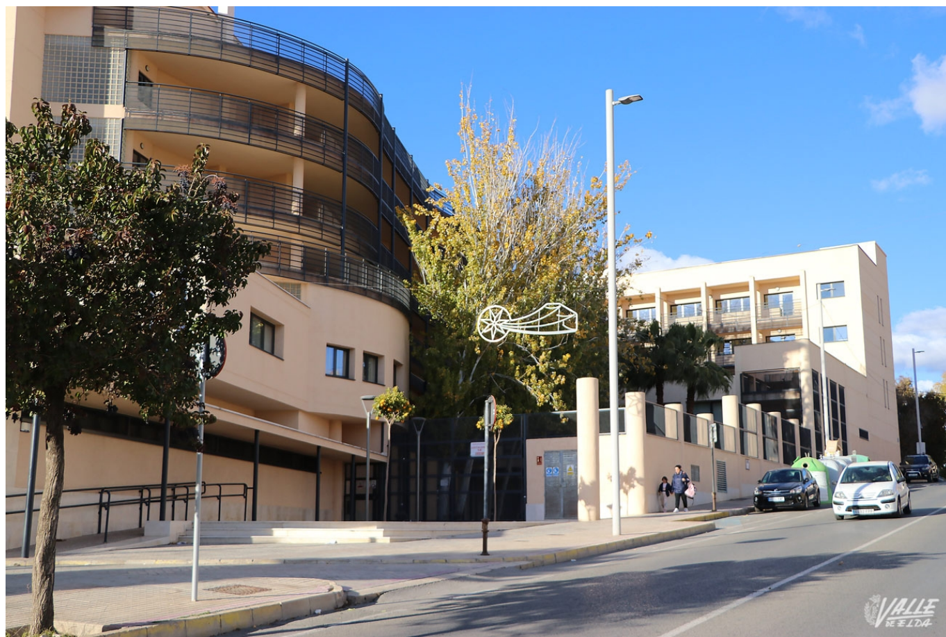
Las obras concluyeron en 2024 y la nueva ala continúa cerrada | Marta Maestre.
