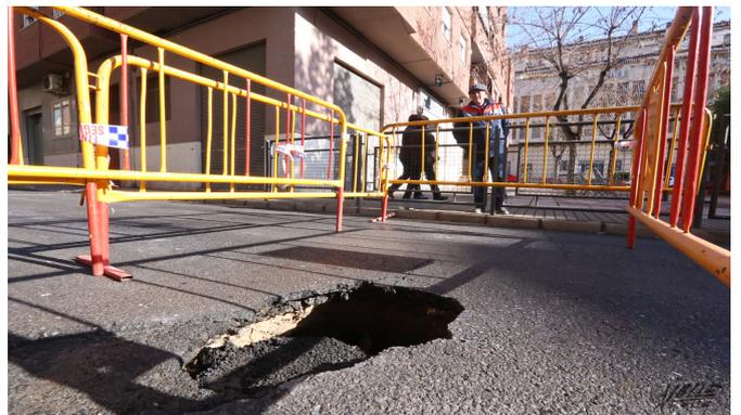
El agua y la humedad han provocado el hundimiento del asfalto. Para comprobar la magnitud de la rotura, el
