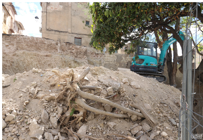
El muro de contención se va a reforzar | Marta Maestre.
