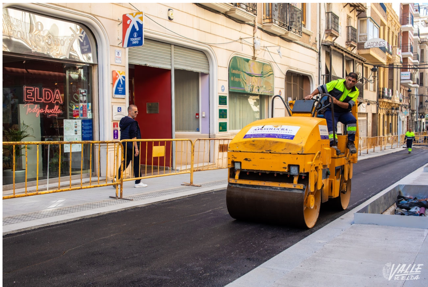
Con el asfaltado arranca la fase final de la obra | Marta Maestre.
