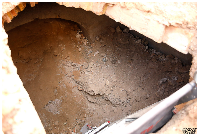
El interior está relleno con escombros | Marta Maestre.
