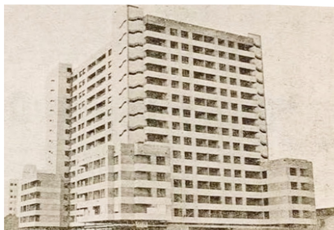
El edificio San Cristóbal tras su finalización en marzo de 1973
