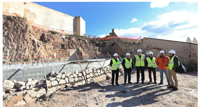
Actualmente se está **construyendo el muro de la ladera del castillo**, para el que se han empleado 200 metros cúbicos de hormigón y pivotes de unos 13 metros.
