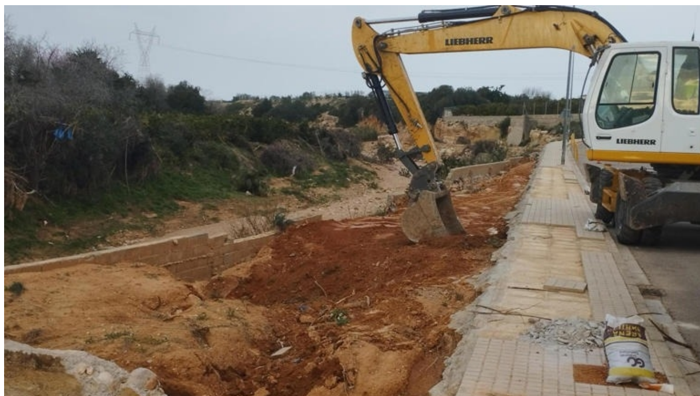
Trabajos de reconstrucción | GVA
