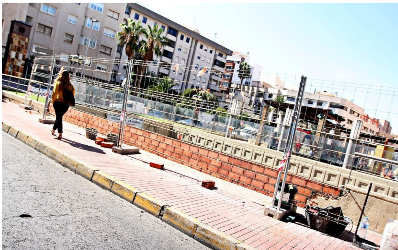
La reparación del muro finalizará antes del fin de semana | Jesús Cruces
