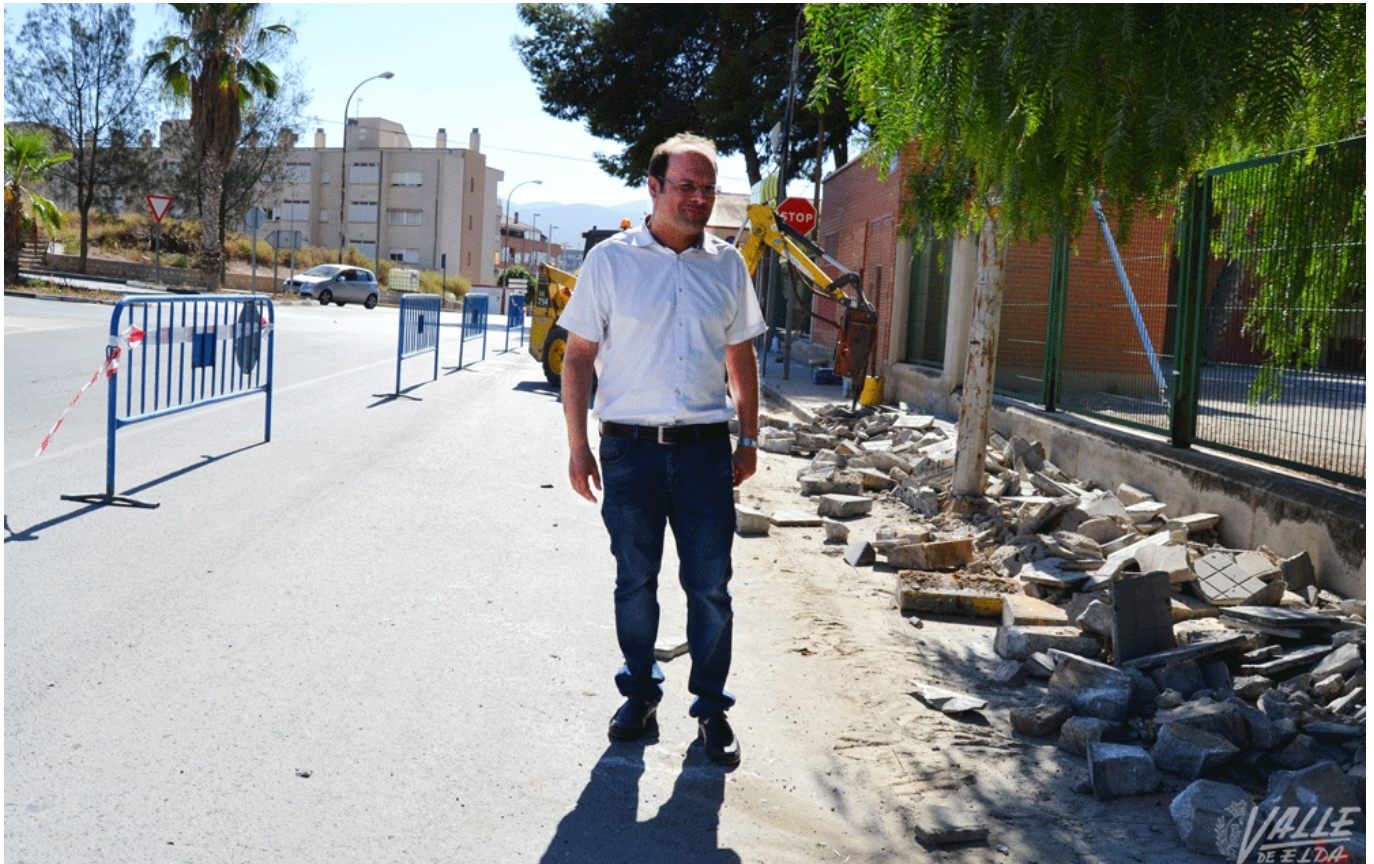
Eduardo Vicente, concejal de Obras e Infraestructuras, inspecciona el estado de las obras | A.J.
