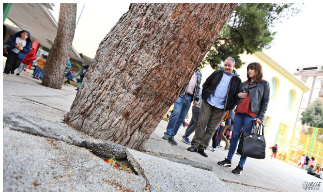
El mal estado suponía un riesgo para los menores | Jesús Cruces.
