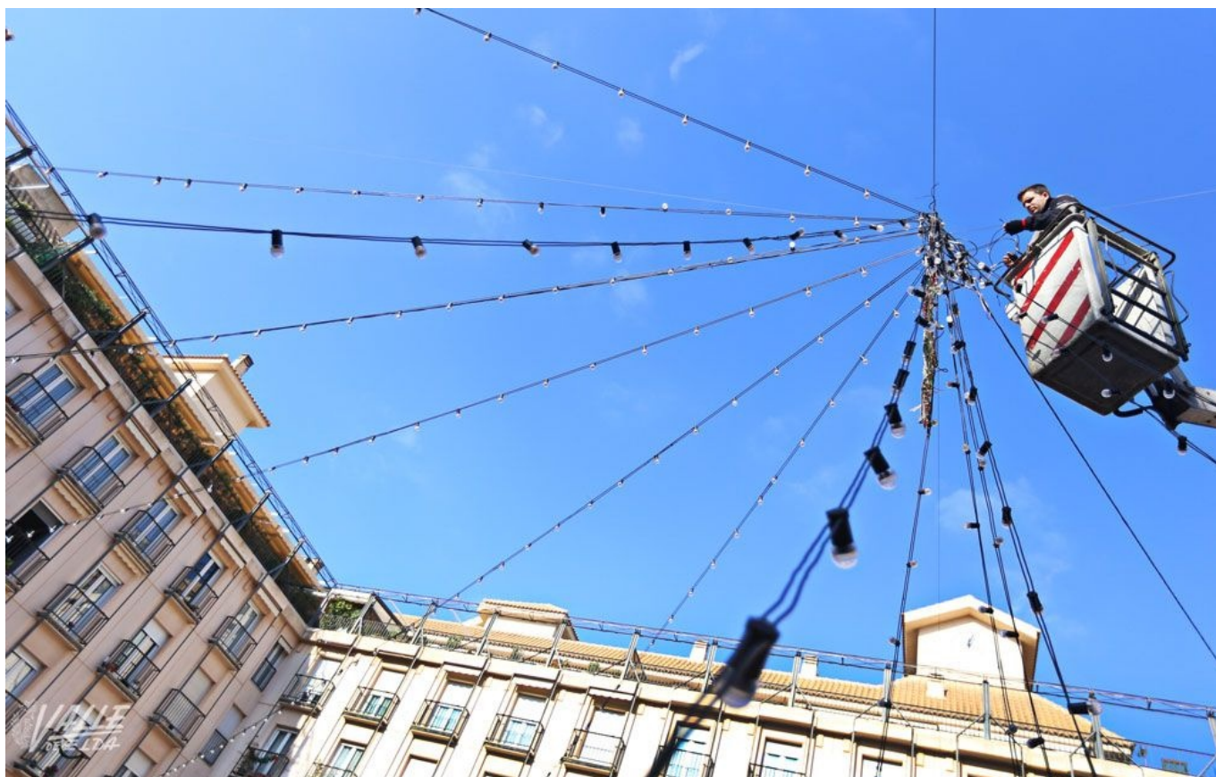
La empresa contratada trabaja en la iluminación de la Plaza Mayor por encargo de los comerciantes | Jesús Cruces.
