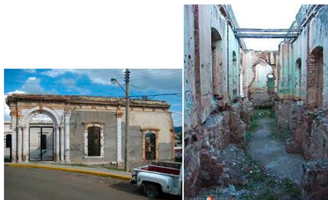
Ruinas de la antigua fábrica del español Arroyo
