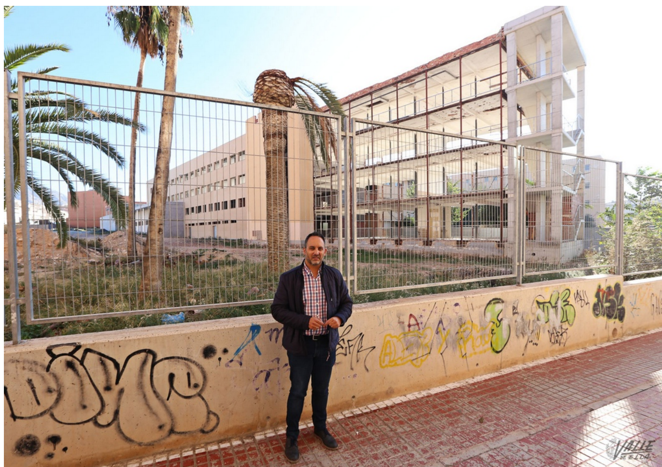
Óscar Payá denuncia la paralización de las obras | Jesús Cruces.
