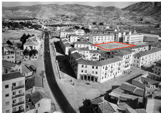
Vista aérea hacia 1966 del barrio Virgen de la Cabeza con señalización de la zona donde se levantó el Convento Franciscano de N o Sra. de los Angeles (1562-1835), el cuartel de la Milicia Nacional de Elda (1835-1841), el Hospital Provincial de Distrito (1864-1892) y el Manicomio Provincial de Elda (1892-1939).
