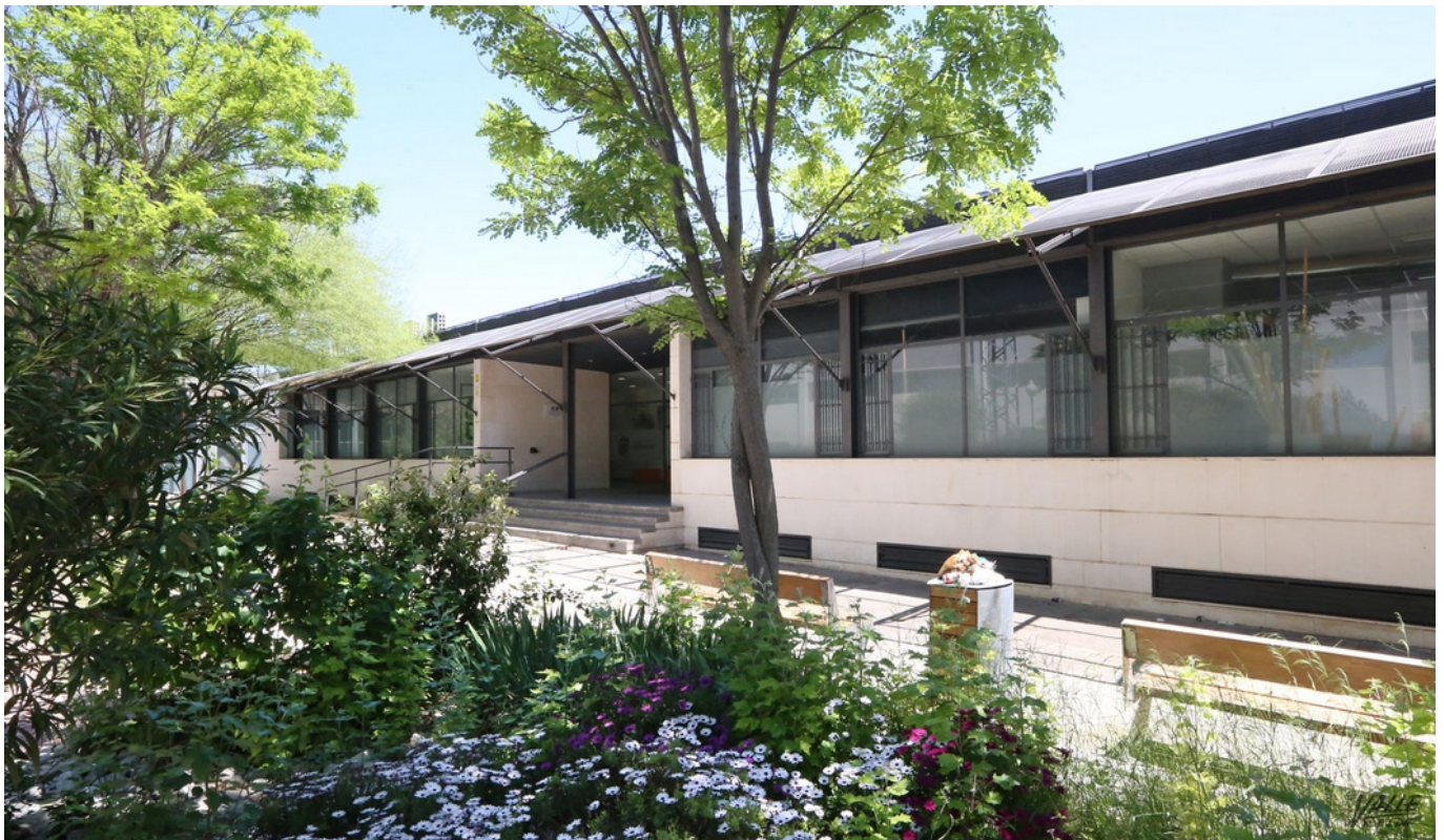
Imagen de las instalaciones de EMUDESА.
