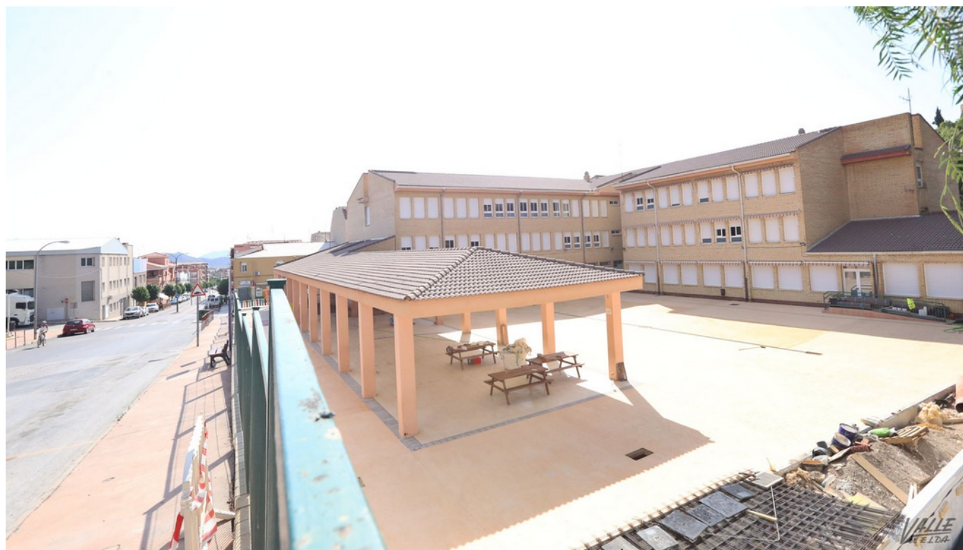
El patio exterior se ha mejorado con hormigón impreso.
