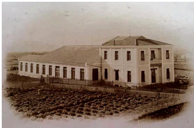
Chalet y fábrica de Rafael Romero Utrilles (posteriormente de Pedro Bellot), en el lugar donde posteriormente se abrirá la calle Dahellos
