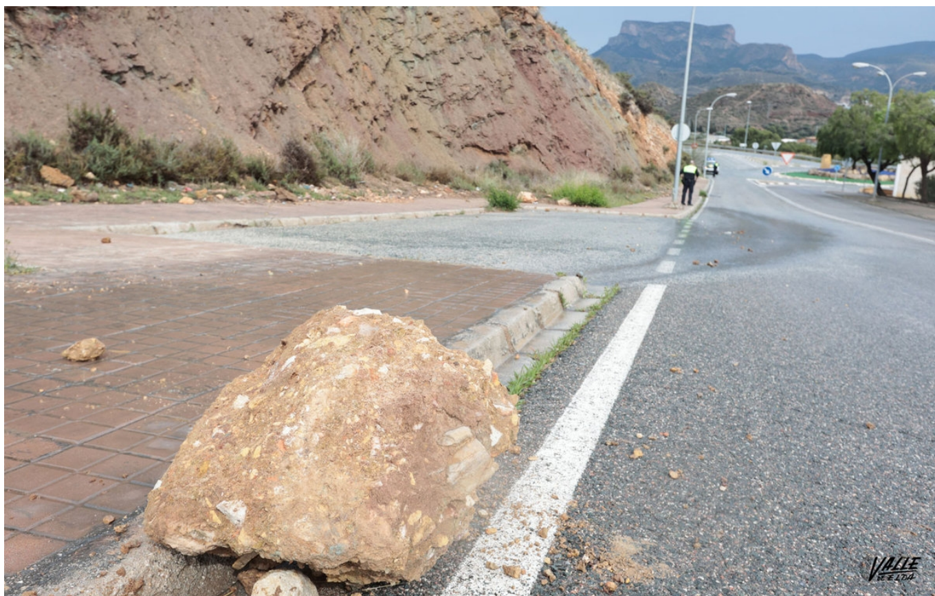
Imagen de las piedras desprendidas.
