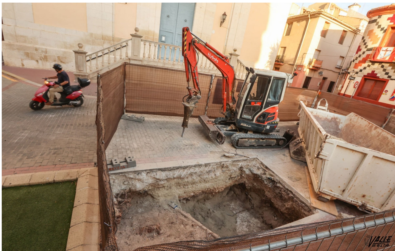
Los trabajos comenzaron esta semana.
