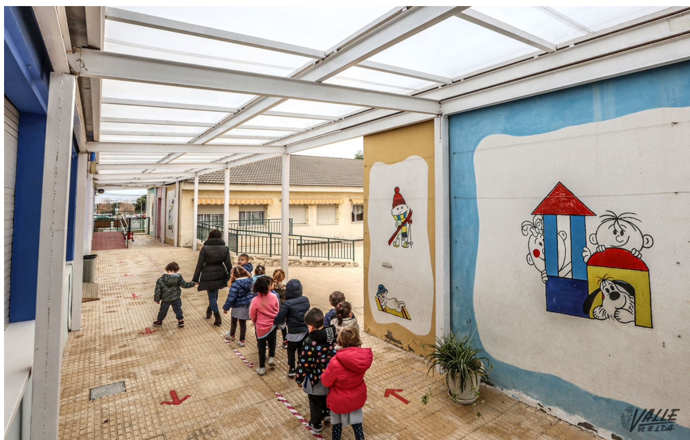
En Nuevo Almafrá se ha sustituido la cubierta de policarbonato que se encontraba en el patio | J.C.
