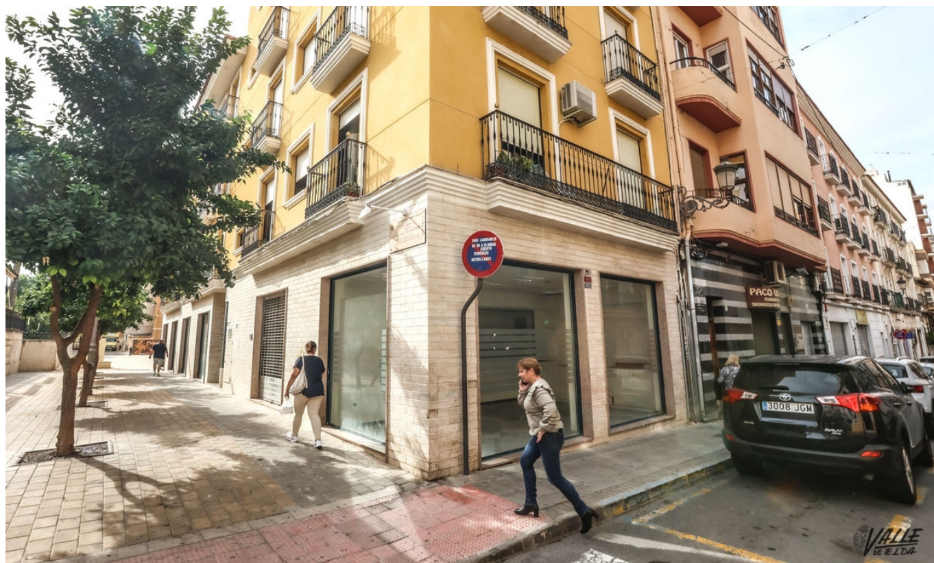
Imagen del local que ha sido forzado.
