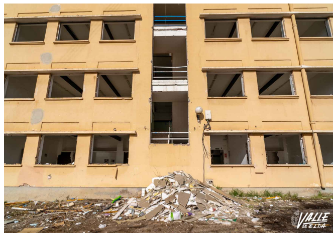
Los trabajos han comenzado con la retirada de las ventanas | Nando Verdú.
