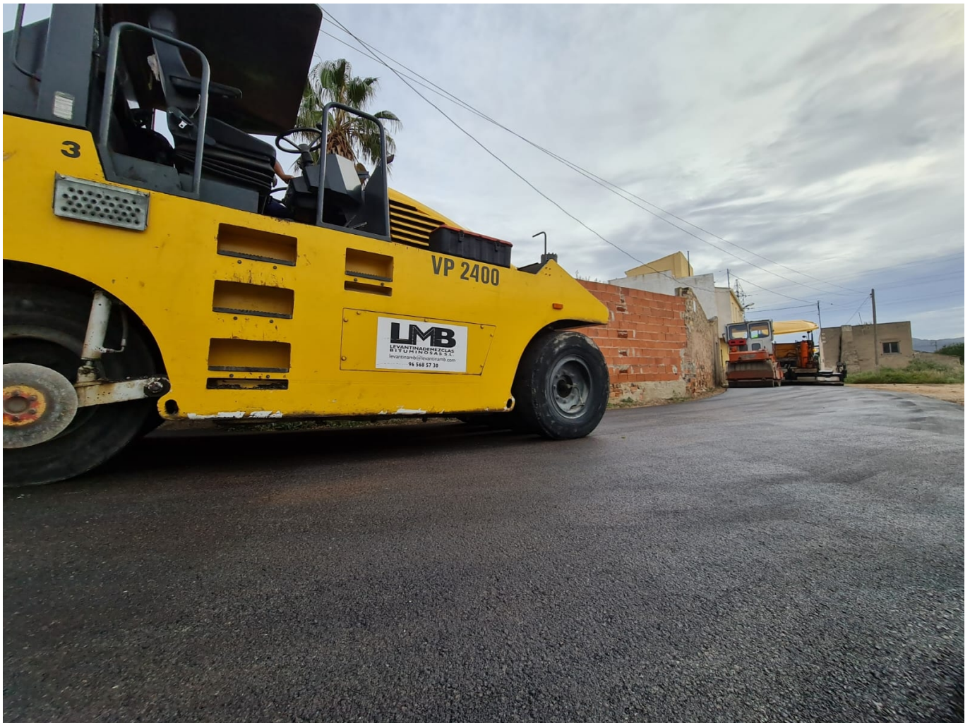
Las obras han permitido el asfaltado de varios tramos del vial que conecta la calle Argos con la calle Andalucía.
