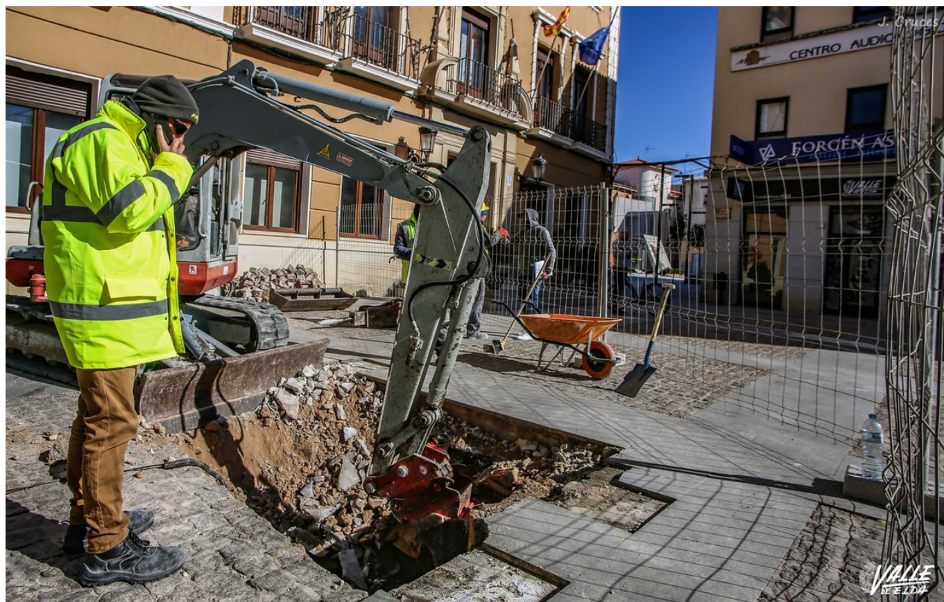
Instalación de la segunda entrada al refugio.
