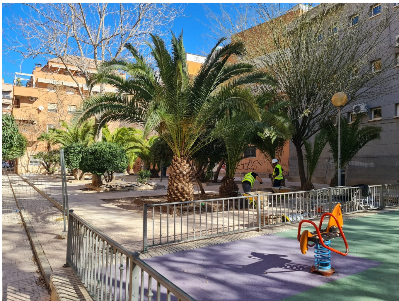
Las obras han comenzado en esta plaza.
