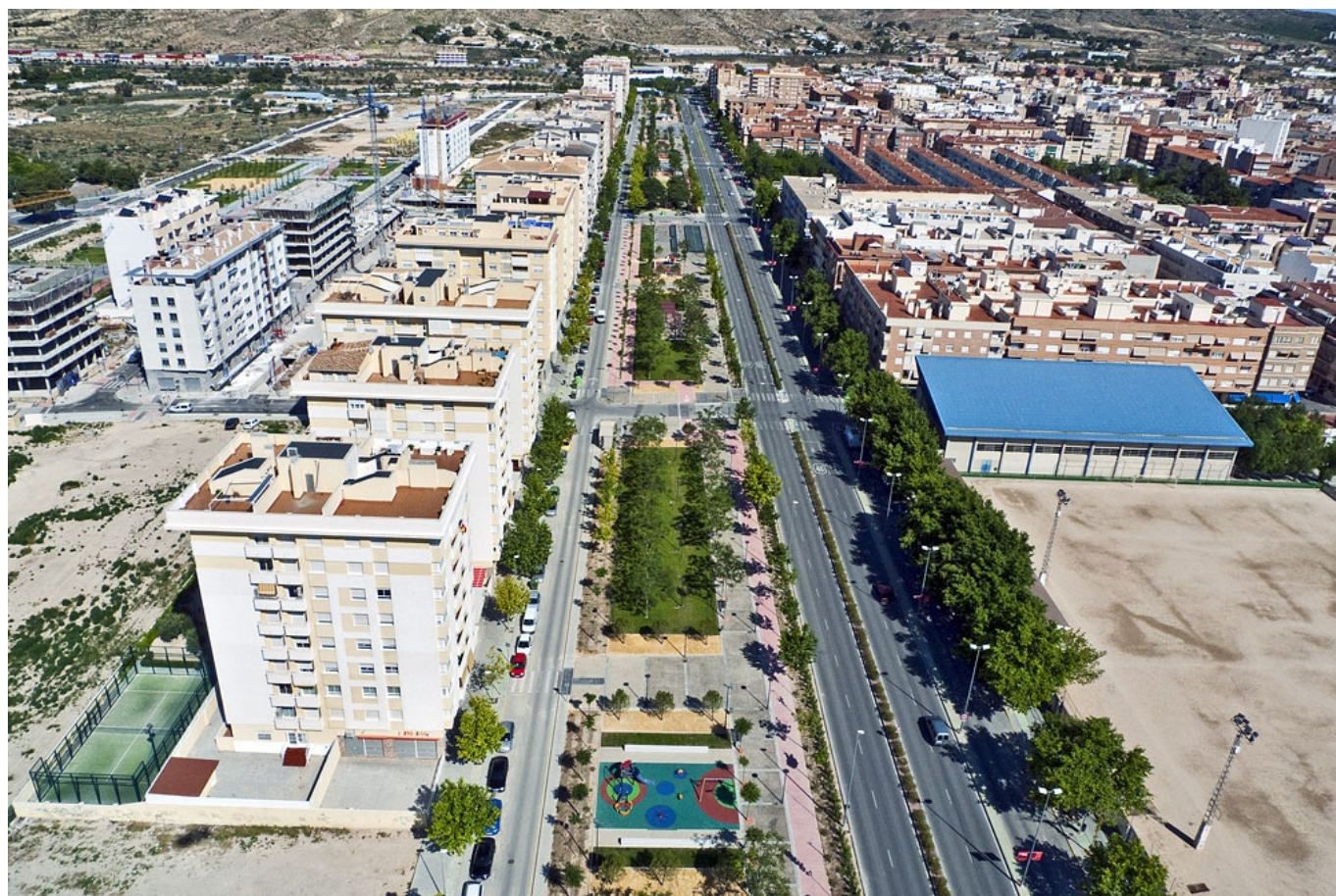
Vista aérea de la Avenida de Ronda
